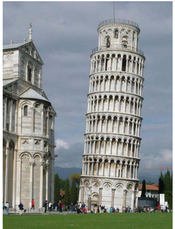
La Torre di Pisa - Dalla Torre Galileo fece i primi esperimenti sulla forza di gravità
